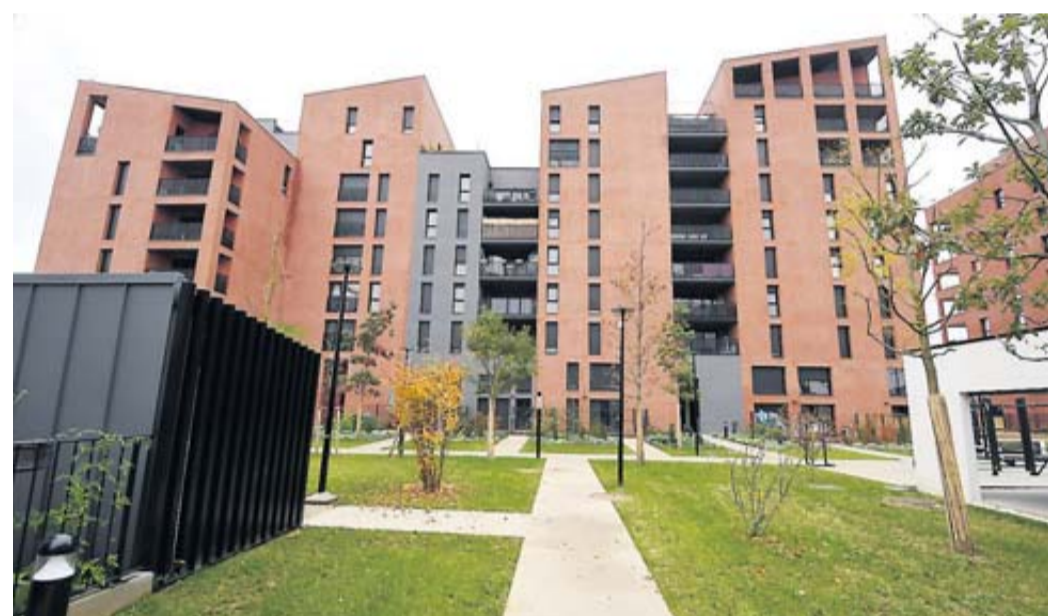
Coûts de travaux du vaisseau amiral de la Cartoucherie : 19 millions d'euros./DDM, Frédéric Charmeux :
