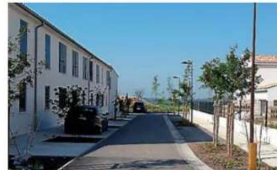
La première tranche de la Zac Les Marquises est achevée.
